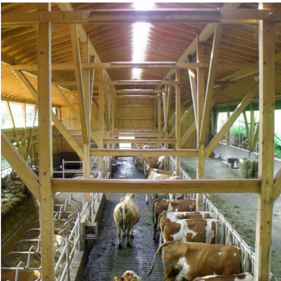
Stall aus zimmermannmäßigem Holzbau mit gängigen Vollholzquerschnitten, regionaltypisch gestaltet
